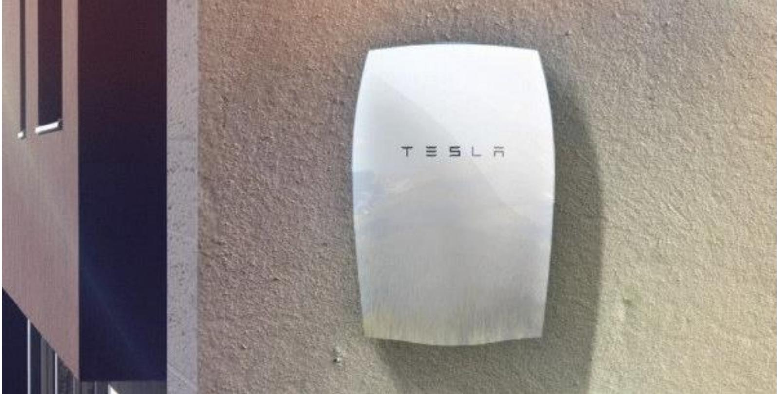
**Name des Stromspeichers:** „Tesla Powerwall 6,4 kWh Solarbatterie“ (E2)
